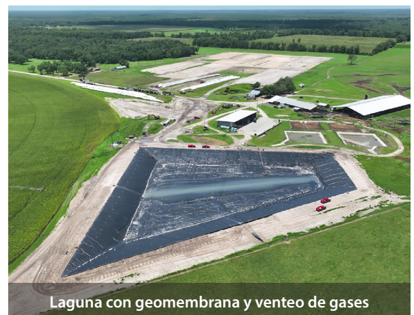
Instalación y anclaje de liner de HDPE
