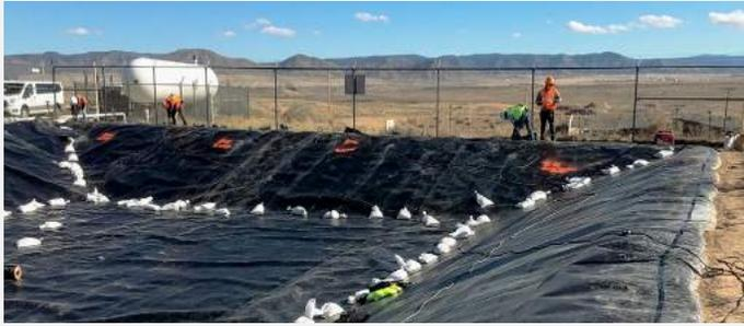
COMANCO completó con éxito un proyecto reciente en el centro de Nuevo México, que involucró la instalación y el reemplazo de un revestimiento de HDPE liso de 80 mil en un estanque utilizado para capturar agua contaminada de los ejercicios de entrenamiento de rescate de incendios. El superintendente David Hina dirigió el proyecto, que se terminó **dos días antes de lo previsto** en febrero.
